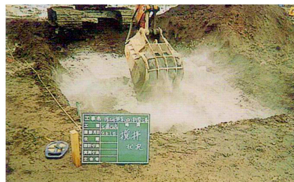
ウルトラコートを5%添加・攪拌1.5M
