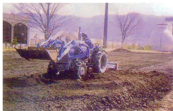
攪拌作業 トラクターにて均一になるまで混合する
