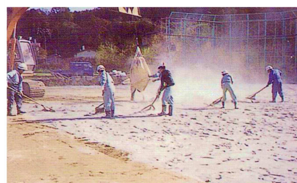
ウルトラコート散布 投入量3%
