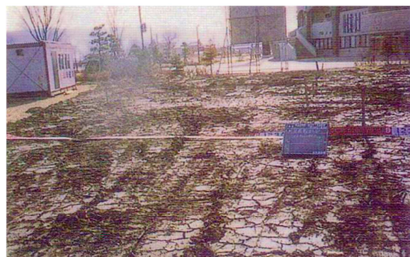
浚渫ヘドロにウルトラコートを添加して改良
