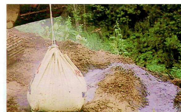
崩壊した法面を表層30cm取り、ウルトラコート 3%添加
