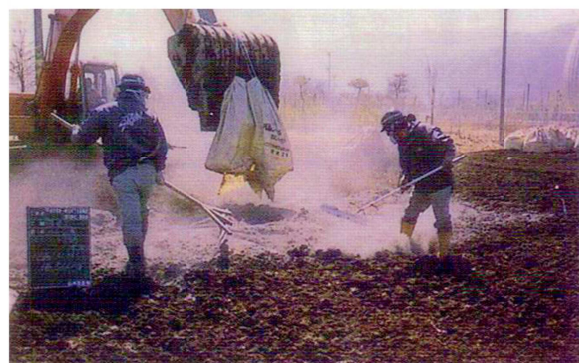
散布作業 ウルトラコートを7%添加
