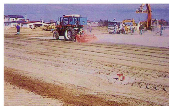
攪拌作業 深さ30cm
