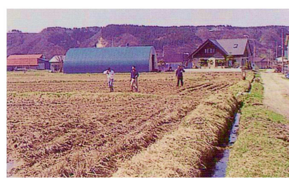
水田を整地し盛土搬入
